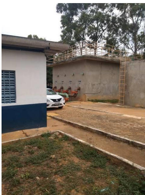
Foto 14 – Estação de Tratamento de Água - ETA
