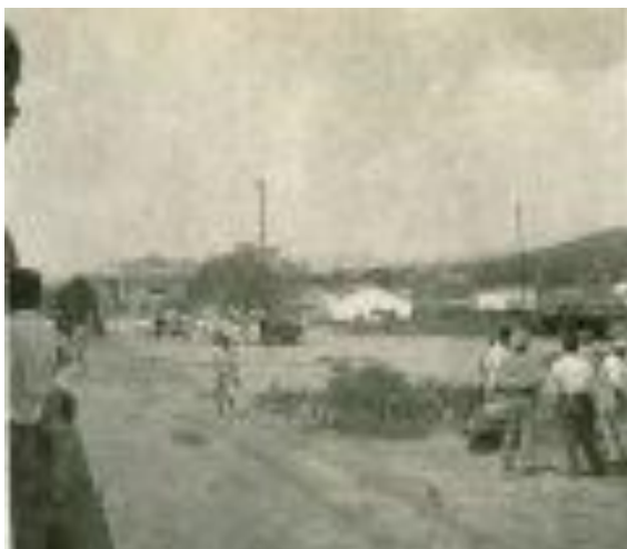
Foto 1 – Estação Ferroviária – 1950 (Foto IBGE)
