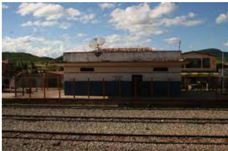
Foto 2 – Estação Ferroviária – 2008 (Foto Valdir C. Barbosa)
